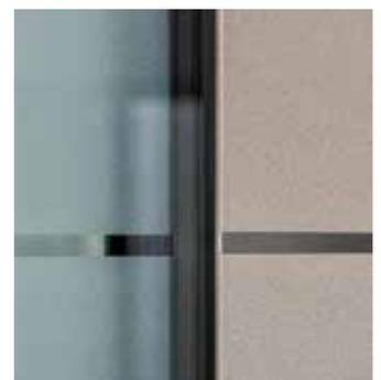
**Nuten**, bündig eingefräste **Edelstahllisenen**, mit teilmattiertem Glas
